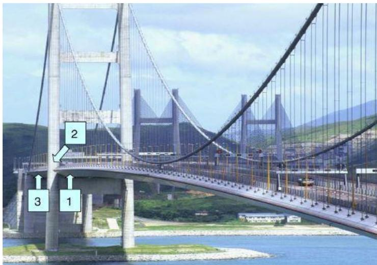
**Figura 60 Punti di applicazione dei sensori FBG sul ponte TSM (Hong Kong)**
