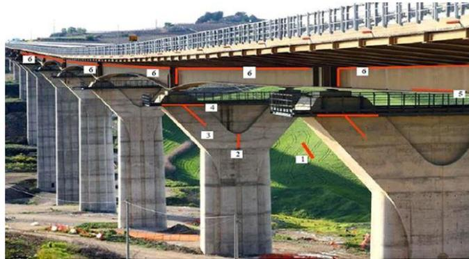
**Figura 43 Ponte strumentato con sensori FBG**
